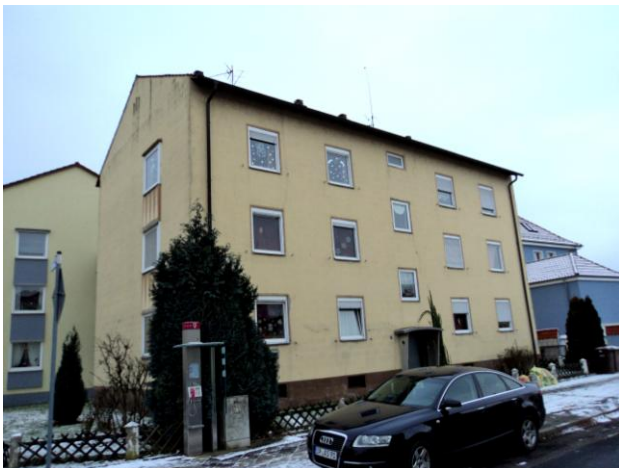
Wohnhaus vor der Sanierung
