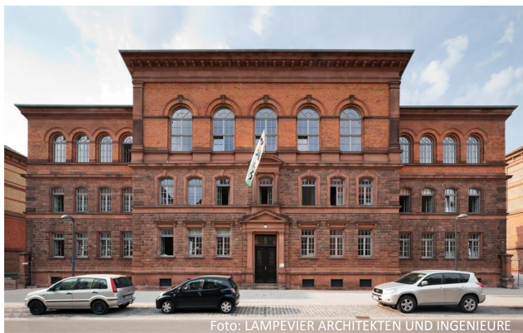
Foto: LAMPEVIER ARCHITEKTEN UND INGENIEURE
